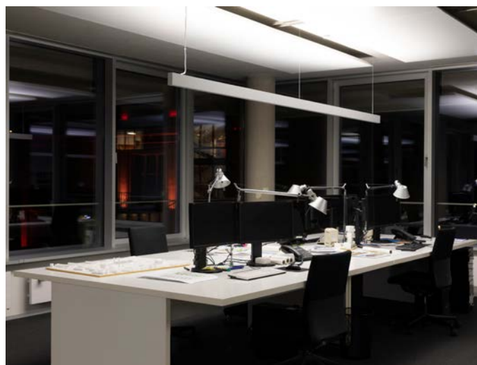
Abb.: An den Arbeitsplätzen wählte man die LED-Pendelleuchte »Linargo« mit einer getrennt schaltbaren Direkt-/Indirektbeleuchtung.
